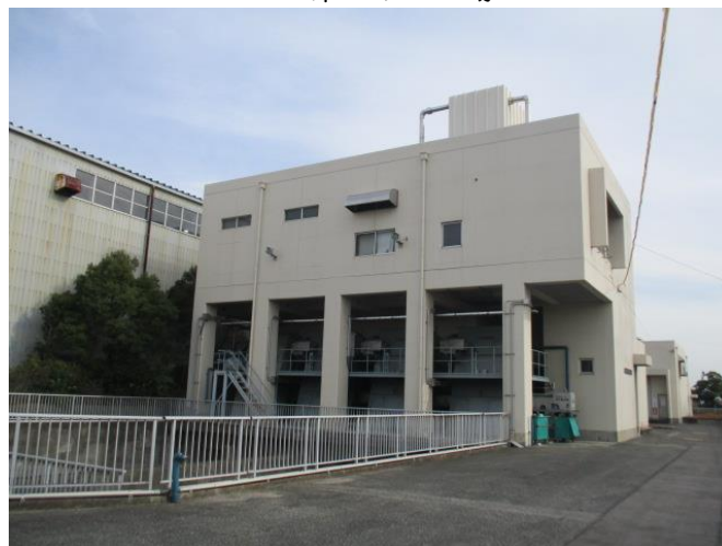
上ヶ第 1 ポンプ場
